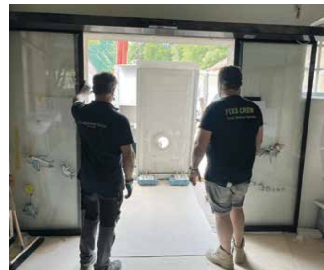
Genau zwei Zentimeter Platz in jede Richtung reichten aus, um den Schlitten mit dem inzwischen mehr als drei Tonnen schweren Aquarium durch die Tür ins Haus zu schieben.
