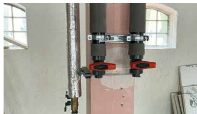
Ende März: die Druckwasserleitungen für Osmosewasser sowie Mischwasserleitungen zu den einzelnen Modulen sowie die Lüftungskanäle sind verlegt, die Decke kann teilweise verschlossen werden.
