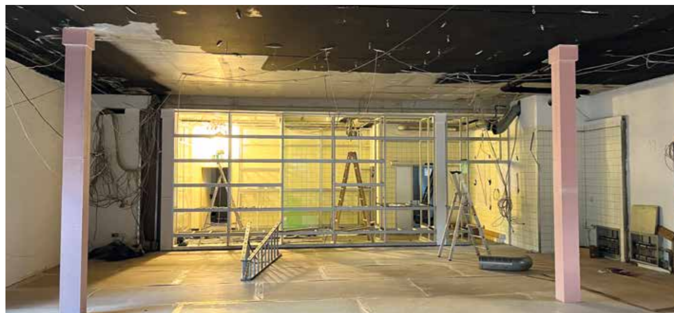
So sah sie aus, die Ausgangslage Anfang Februar 2023. Die Regale für den Zuchtraum stehen im Hintergrund schon. Doch bevor es losgehen kann, müssen erst sämtliche Wasserleitungen, Lüftung und Elektrik an die Decke gebracht werden.
