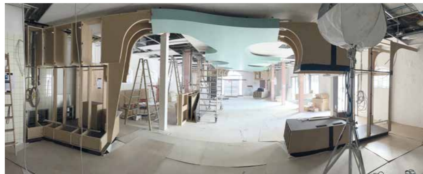
Meisterhandwerk: Ende März montiert die Firma Schirm die Deckenkonstruktion der „Krake“
