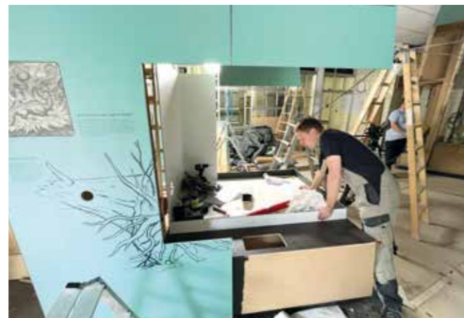
Jedes einzelne Modul war zuvor einmal in der Tischlerei komplett zusammen- und wieder auseinandgebaut worden, um die Passgenauigkeit zu überprüfen. Jede der sichtbaren Verkleidungsplatten ist mehrfach lasiert und anschließend von der Druckerei in einem mehrstufigen Verfahren bedruckt worden.
