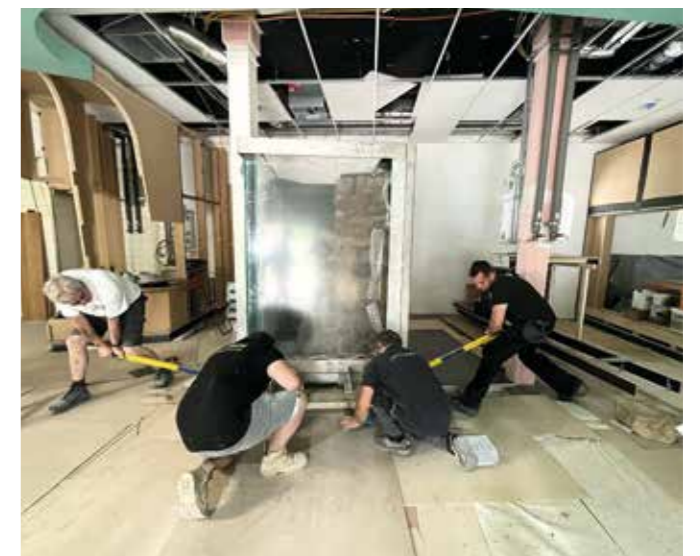
Starke Männer braucht das Aquarium. Am Ende saß das Teil zentimetergenau am rechten Platz. Erst dort wurden die Acrylplatten eingeklebt und abgedichtet.
