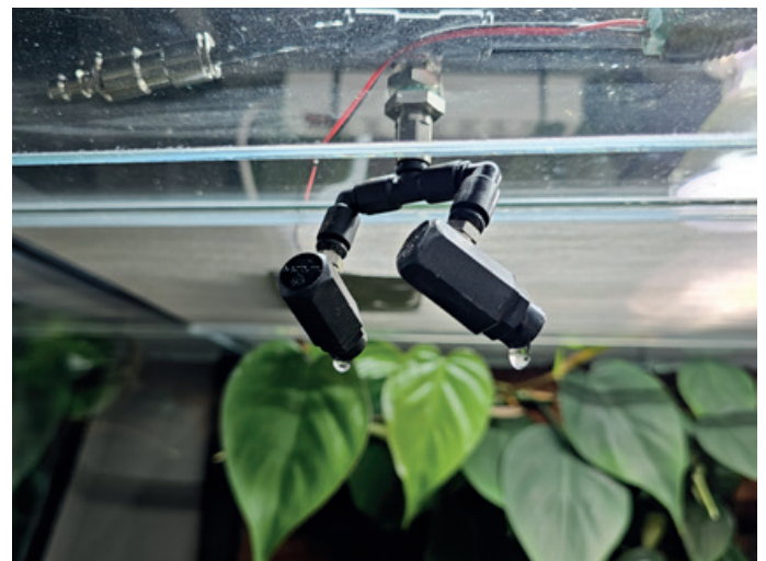
Austrittsdüsen einer Beregnungsanlage | Heiko Werning
